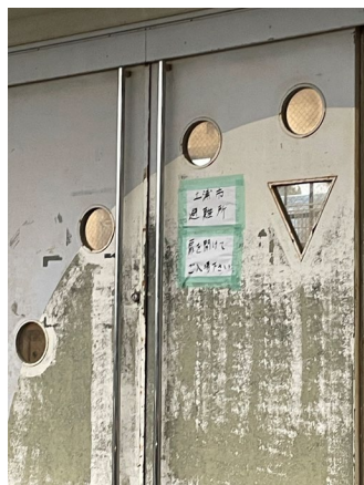
四中体育館の避難所入口
